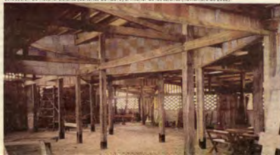
Colocación de material aislante (cartones de huevo) al interior de los salones (noviembre de 2002)
