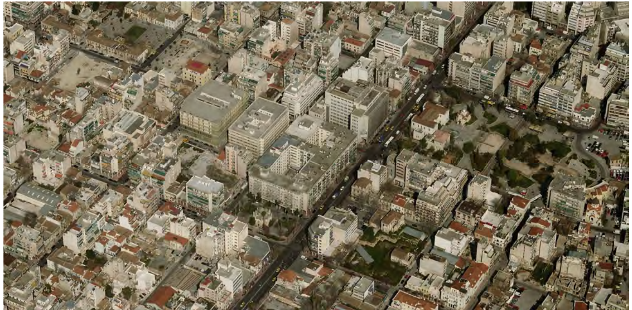
Εικ. 2.1. Αεροφωτογραφία του συγκροτήματος και της γύρω περιοχής απο Νότια (πηγή: Bing Maps)
