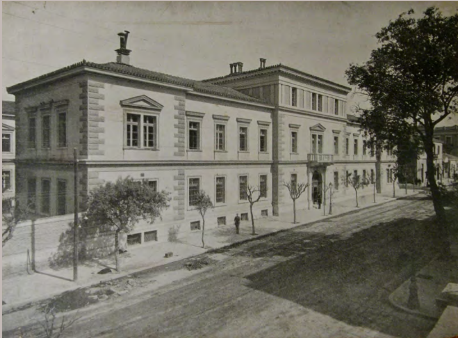
Εικ. 2.9. Εξωτερική όψη του παλιού συγκροτήματος του Ορφανοτροφείου απο την οδό Πειραιώς (πηγή: Ίδρυμα Χατζηκάνστα)
