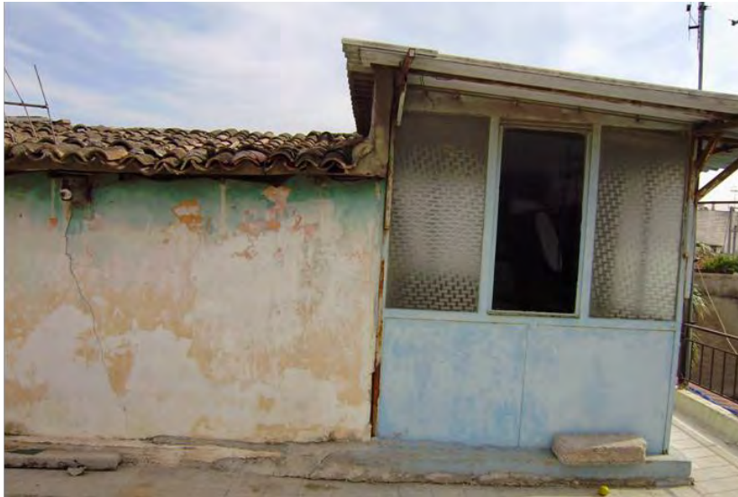
Το πλυσταριό της ταράτσας με πρόσθετο τμήμα αλουμινοκατασκευή
