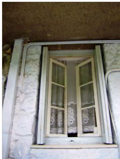
Εξωτερικοί σωλήνες ύδρευσης
