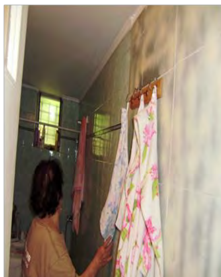
Στο στενό μπάνιο της αρχικής κατοικίας προστέθηκε ένα τμήμα που βγαίνει στην αυλή. Το σημείο προσθήκης φαίνεται εκεί που ενώνονται τα πλακάκια.
