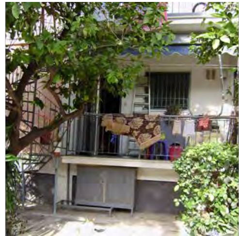
Μεταλλικό ντουλάπι αποθήκευσης κάτω από το μπαλκόνι
